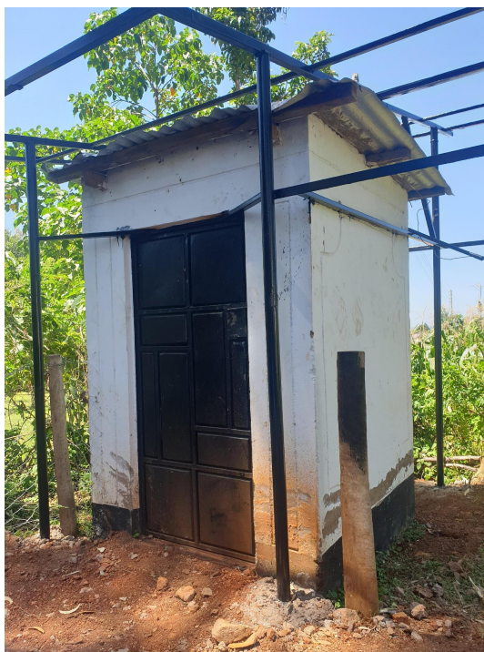
Transformatorhuset med ställningen för solpanelerna
